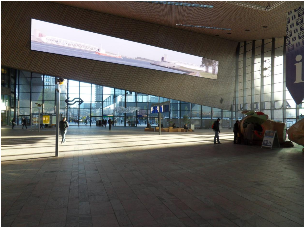
De ruim bemeten entreehal van Rotterdam Centraal, op het scherm de Nieuwe Waterweg met Maeslantkering
